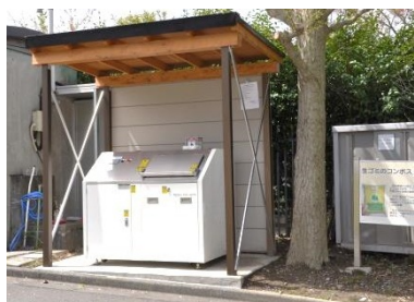
緑園キャンパスに設置された生ごみ処理機。生ごみを良質な堆肥に再生し、その堆肥を活用して地域の農家で作られたエコ野菜が学食で提供される。
